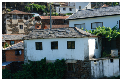
EB1 de Telhe
