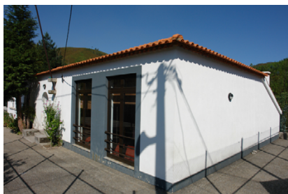
EB1 de Ponte de Telhe
